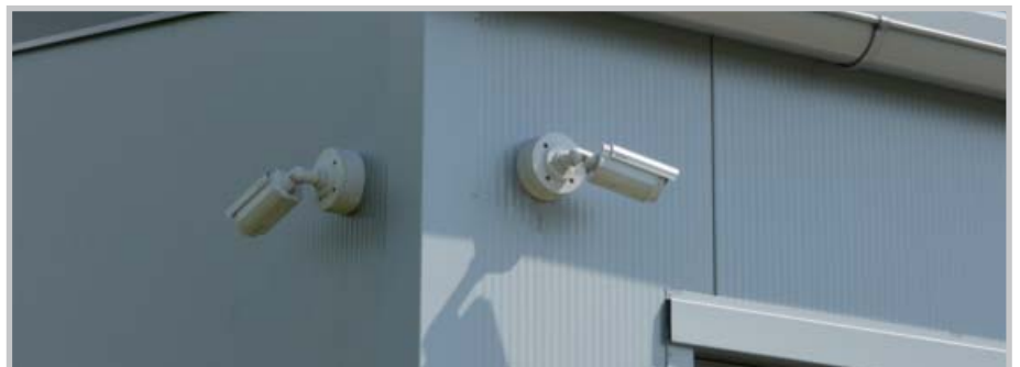
Bei einer späteren Umstellung auf IP-Megapixelkameras ist der Aufwand sehr gering.
